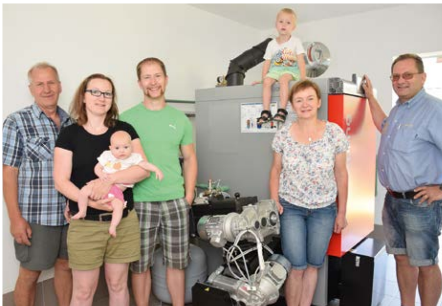
Das neue Herzstück in der Energieproduktion für die Heizung dem Bauernhof der Familie Bachler in Purgstall: der Fröling Hackschnitzelkessel T4 mit 50 KW Leistung.
